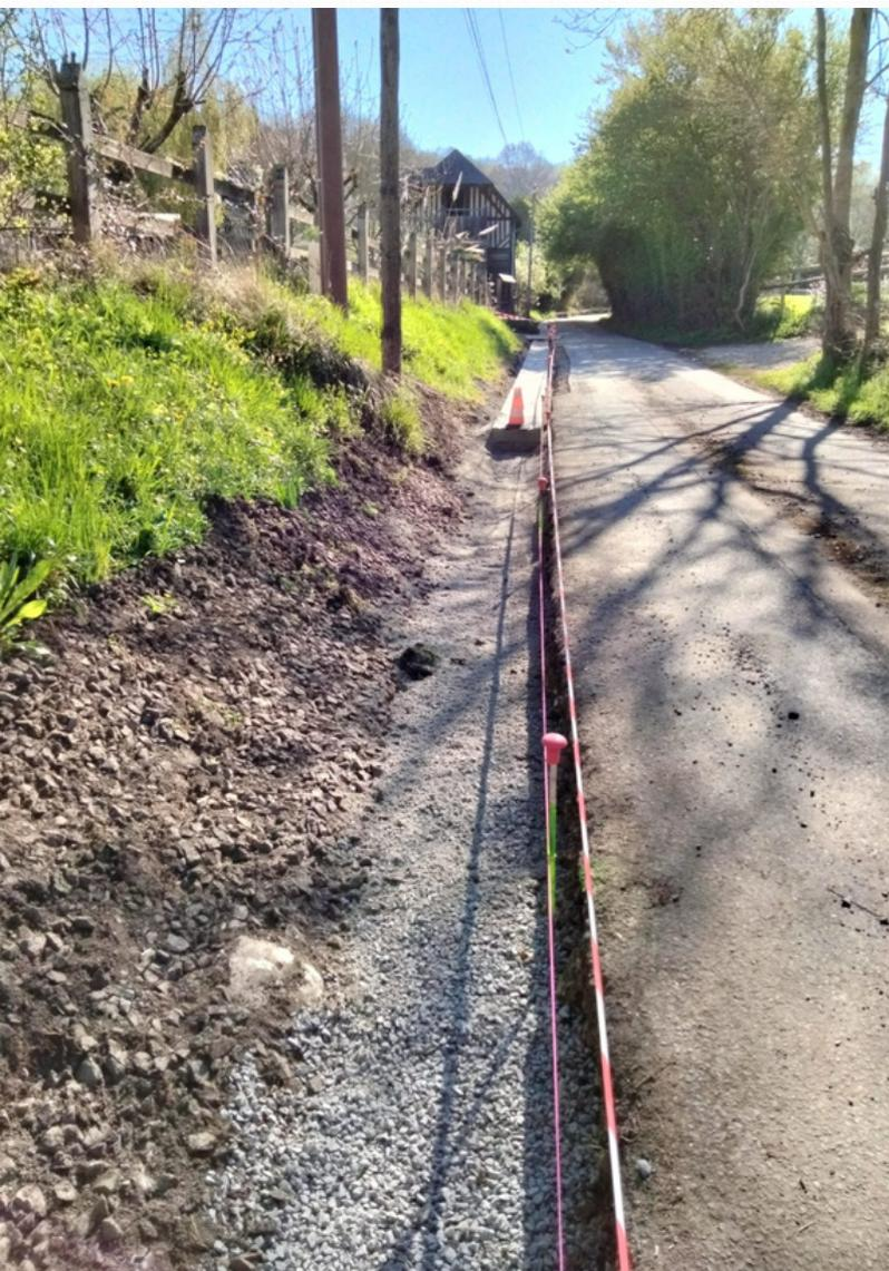
Préalable indispensable à la réfection de leur chaussée, l'assainissement pluvial des chemins de Pontfol et de la Planche aux Mignots a consisté en un busage des zones les plus adaptées, la pose de caniveaux CC1 lorsque cela était possible et l'installation de nouveaux regards. Opération cofinancée par le conseil départemental.
